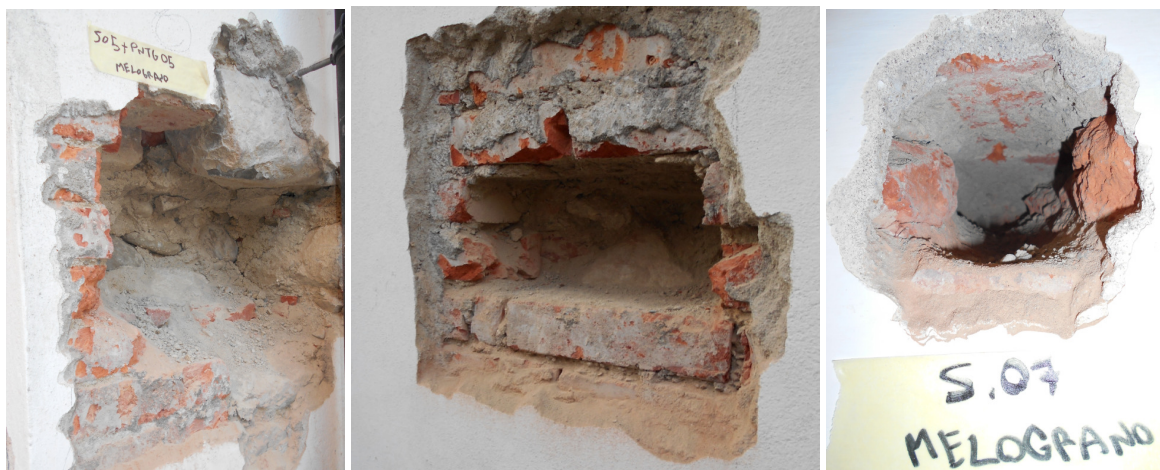
Saggi S05-07-01 (parete esterna con paramento principalmente in mattoni pieni e nucleo interno)
