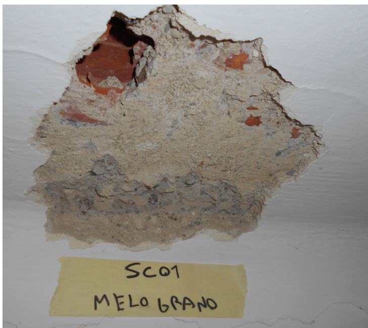
Saggio SC01 (solaio in laterocemento con cordolo)
