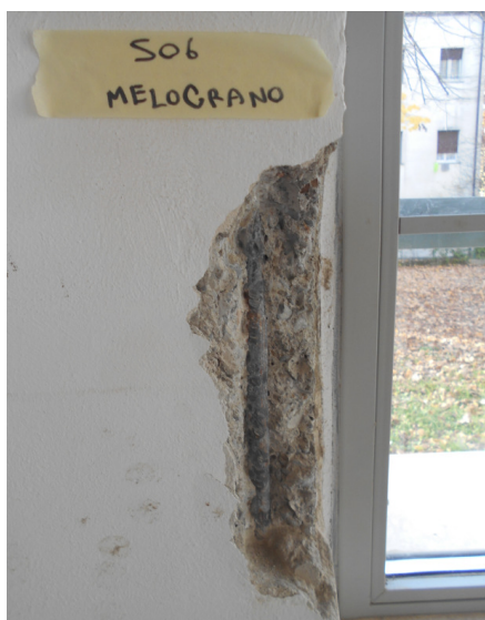
Saggio S06 (presenza di pilastro privo di staffe)
