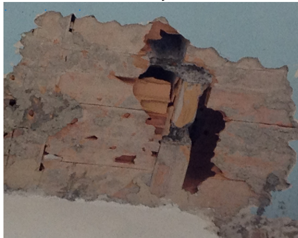
Solaio in laterocemento ad orditura incrociata
