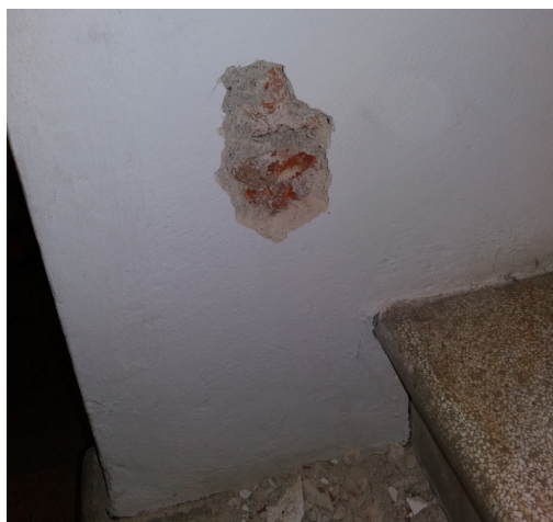
S.11 – scala ampliamento poggianti su muratura a mattoni pieni
