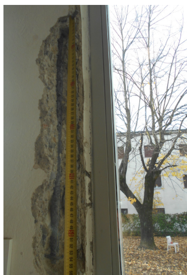
Saggio S06 (presenza di pilastro privo di staffe)
