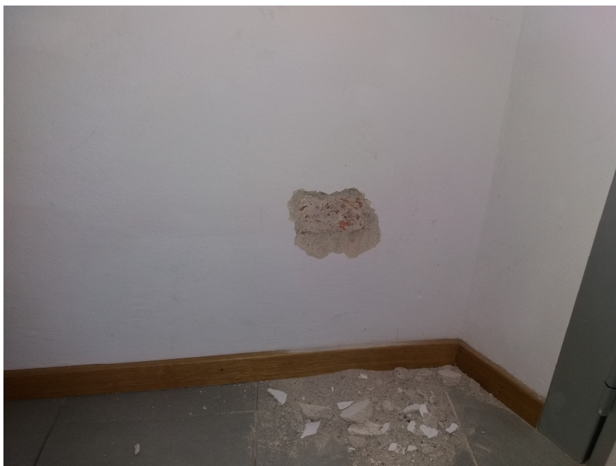
S.10 –Saggio pareti secondo piano ampliamento
